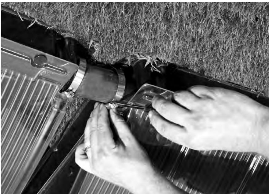
Raccordez le dernier tube de sortie "To Pool" (Vers la piscine) à la piscine.
