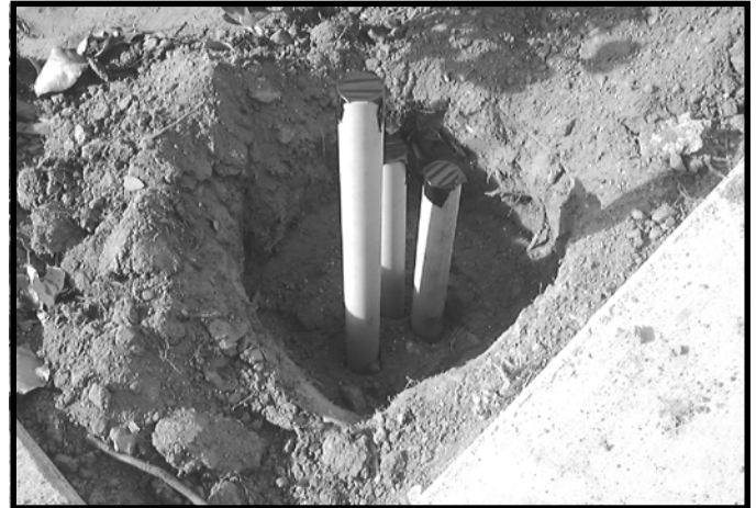
1. Conduits set per PG2000 template.
